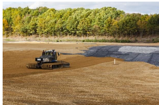
IAA Teich 4 in Freital, Aufbringen der Drainageschicht (Quelle: Wismut GmbH)
