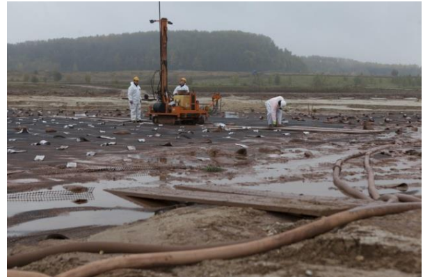
IAA Culmitzsch, Einbringen von Flachdrains (Quelle: Wismut GmbH)
