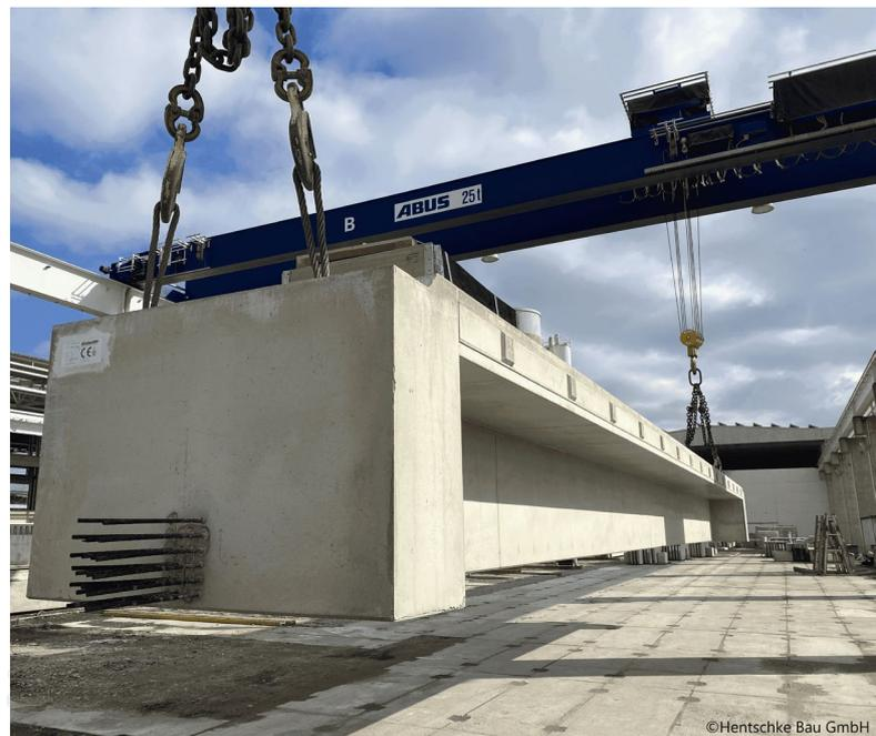
Modulare Bauweise mit nichtmetallischer Bewehrung: Die verschiedenen Bauteile für die Brücke – hier im Bild ein Brückenträger – werden im Werk vorgefertigt, auf die Baustelle geliefert und dann vor Ort verbunden.
