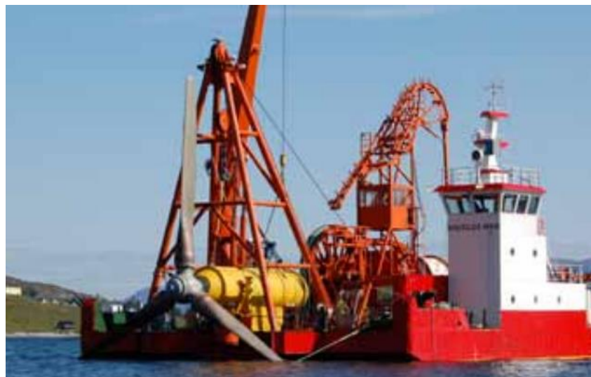
Abbildung 6.15: Gezeitenströmungsturbine der Firma Andritz Hammerfest bei der Installation
