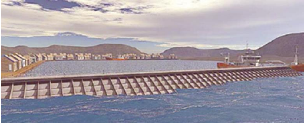
Abbildung 6.22: Seawave Slot-cone Generator (SSG)
