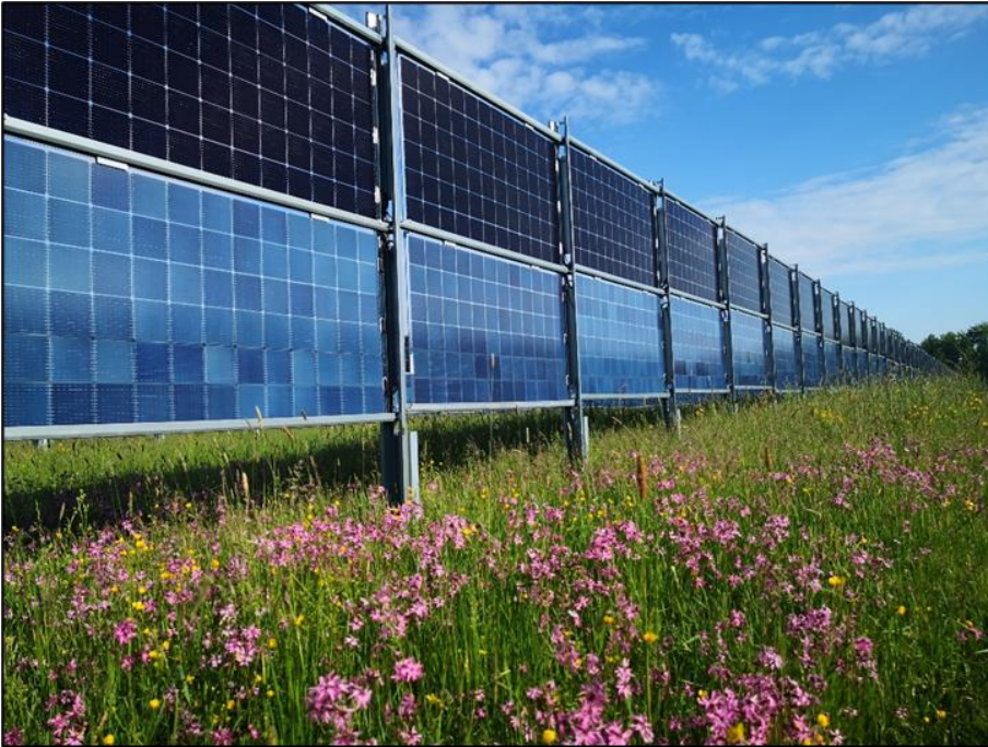
Abbildung 2: Blühstreifen entlang der vertikalen, bifazialen Solarmodule im Solarpark Aasen
