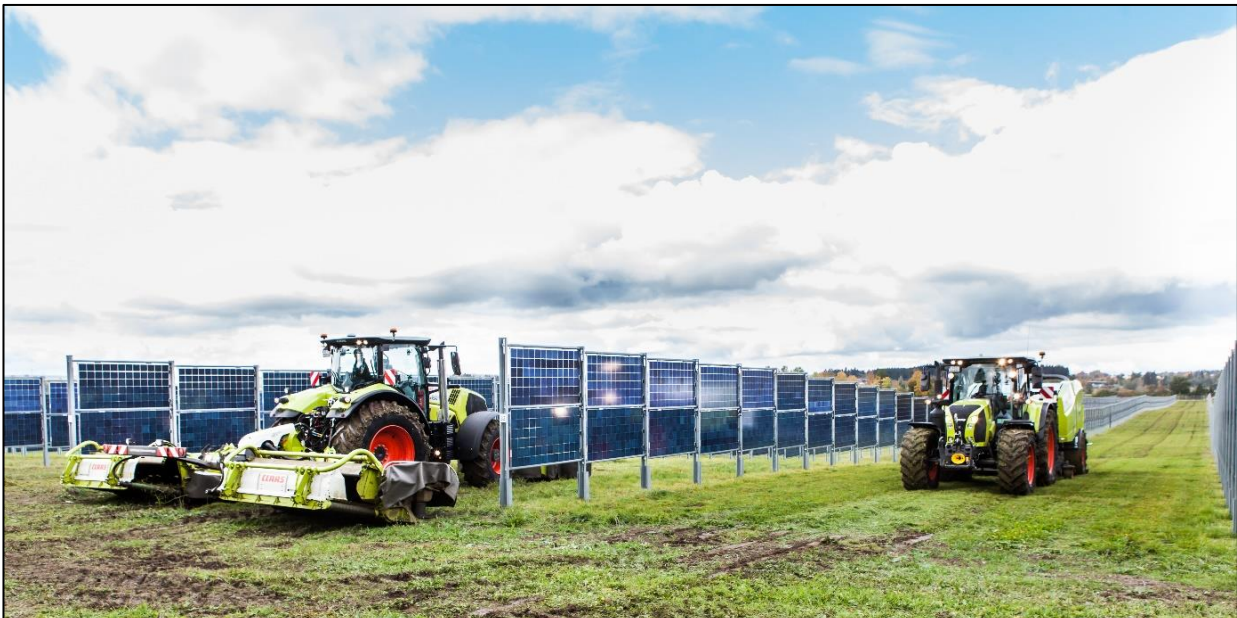
Abbildung 1: Vertikale, bifaziale Solarmodule. Mahd einer Grünlandfläche im Solarpark Aasen (Donaueschingen)
