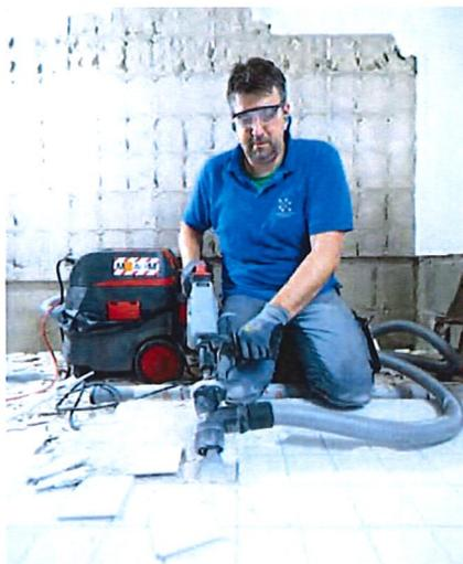
Abb. 1: Neben Schutzbrillen und -handschuhen sollten auch konsequent Knieschützer bei Fußboden- und Fliesenlegearbeiten verwendet werden
