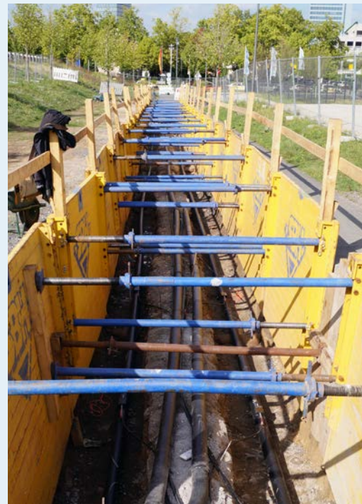
Graben mit Verbauwand aus dem Forschungsvorhaben „Innovative Fernwärmeverteilung“
