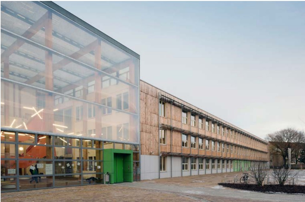
Demonstrationsbauvorhaben EnEff:Schule: Plus-Energie-Schule in Rostock Reutershagen
