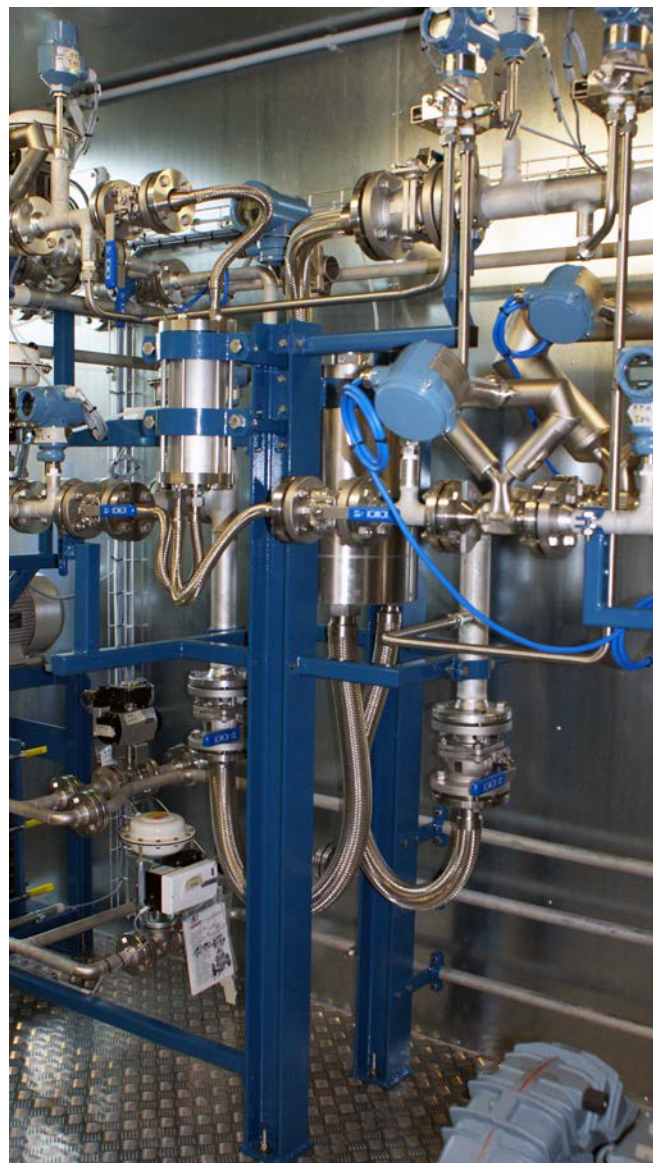
Module mit Polymermembranen trennen CO 2 aus Kraftwerksrauchgasen.
