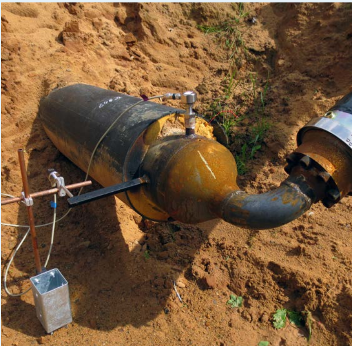
Messtechnik am grabenlos verlegten Kunststoffmantelrohr
