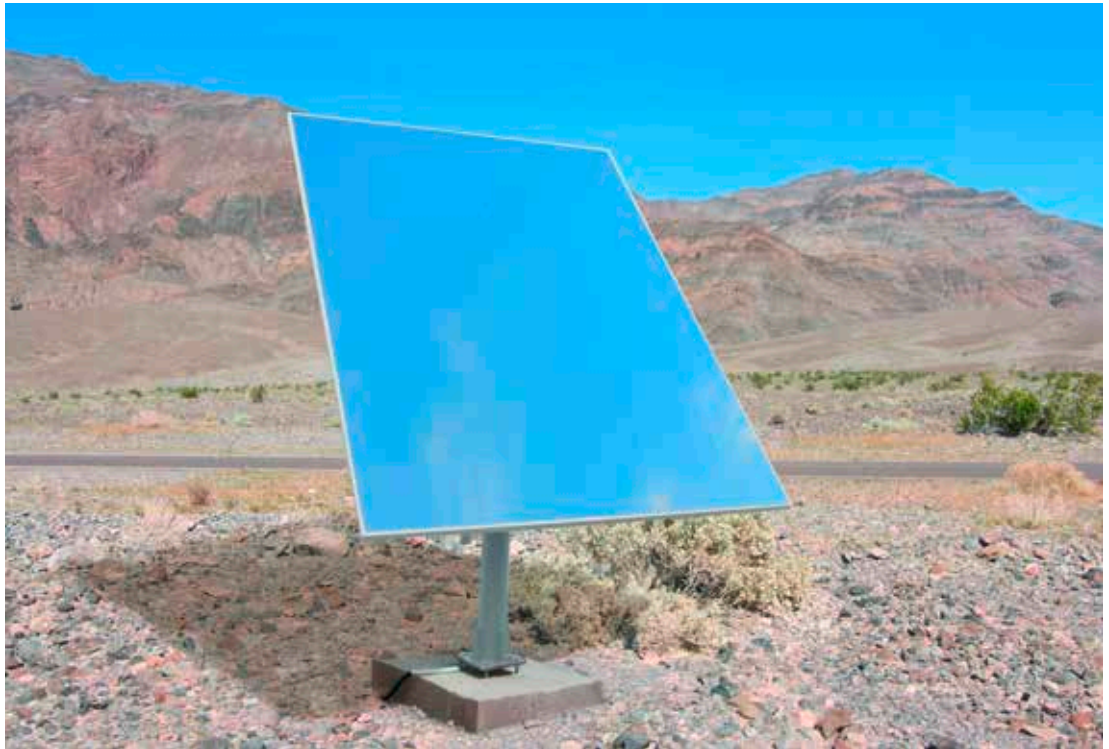
Heliostat der Solar Tower Technologies AG mit fester Horizontalachsenaufhängung
