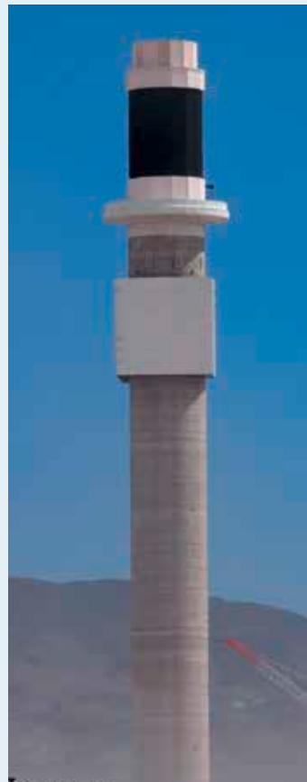
Ein Beispiel für den aktuellen Stand der Technik: der Receiver des Salzturmkraftwerks „Crescent Dunes“ in den USA
