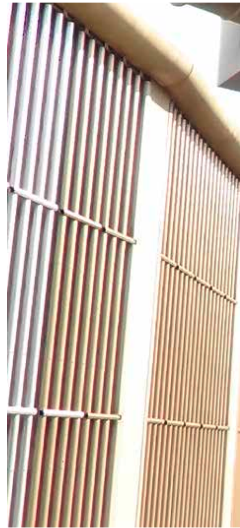
PCC-Pilotanlage zur CO 2 -Wäsche in Niederaußem
