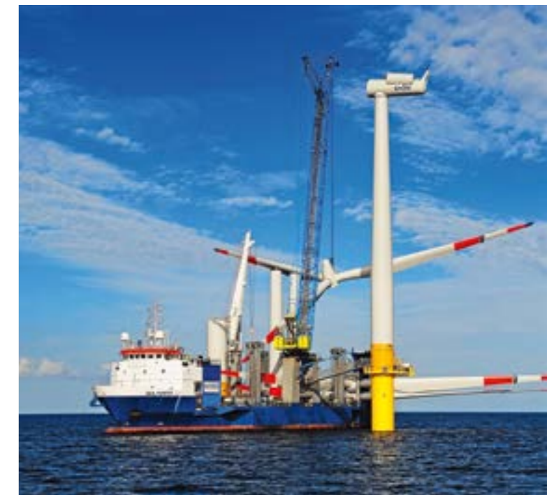
Montage des Rotorsterns im Windpark EnBW Baltic 1.
