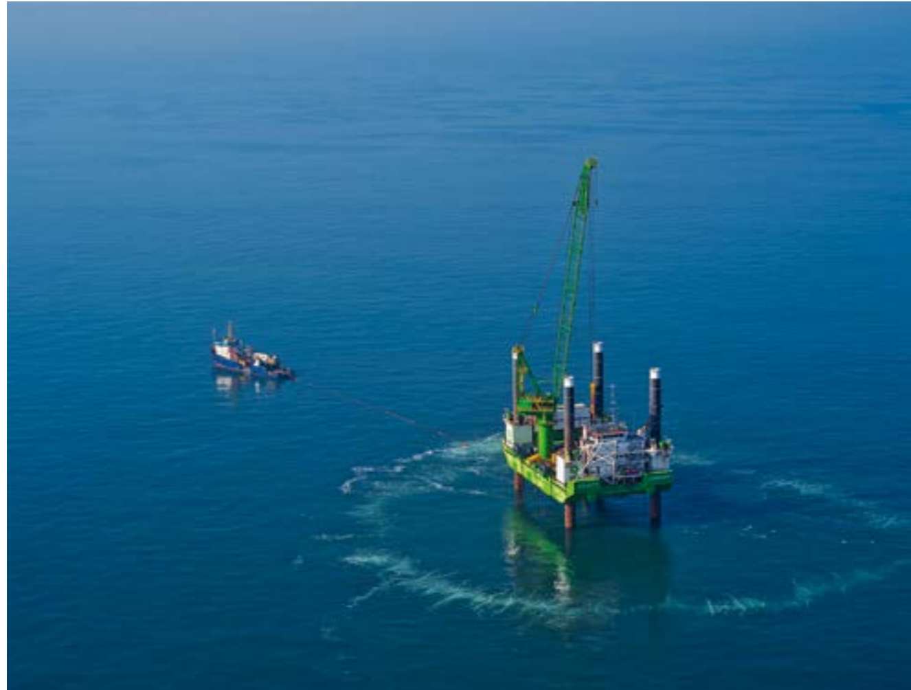
Baustart für den Trianel-Windpark 2011: Bevor das Jack-up-Schiff „Goliath“ die Fundamente einrammt, legt ein anderes Boot einen Blasenschleier für die Schallreduzierung um die Baustelle.
