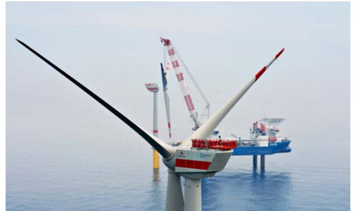
Rotostern-Montage beim Windpark Global Tech 1.
