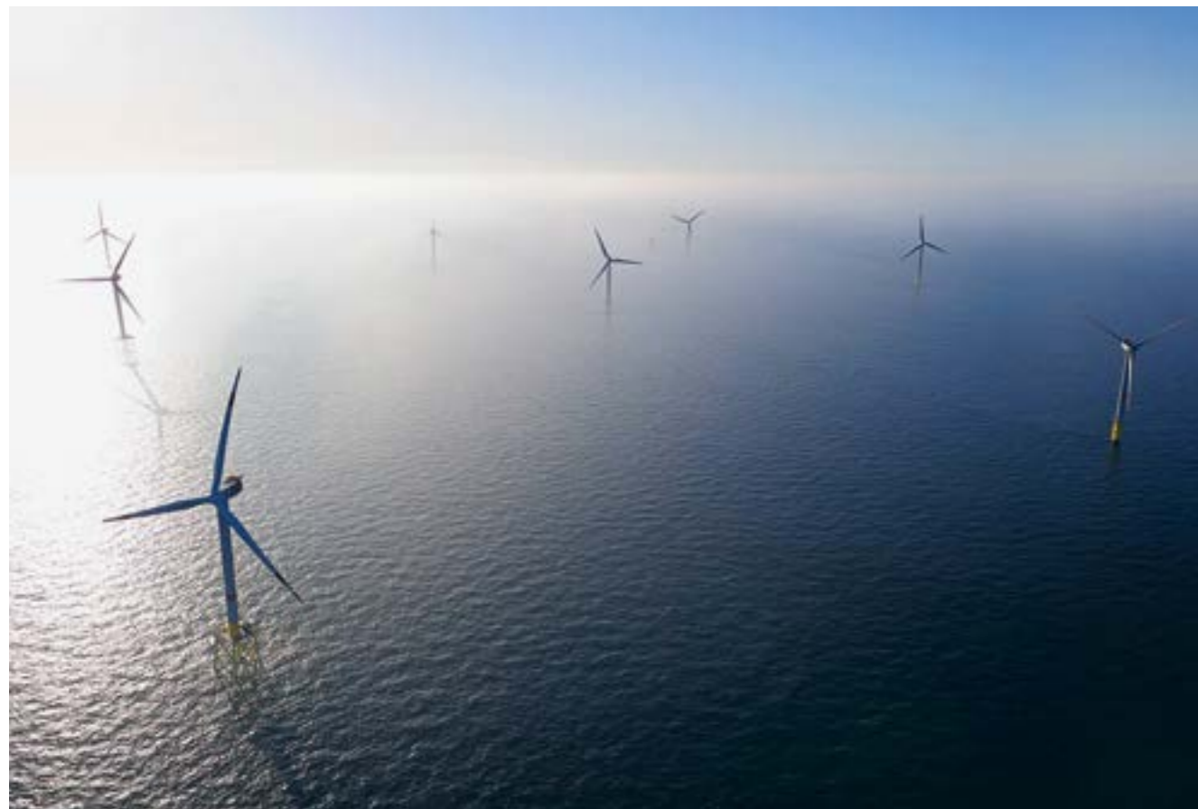
alpha ventus war der erste deutsche Offshore-Windpark überhaupt. Er liefert seit 2009 Strom ans deutsche Netz.
