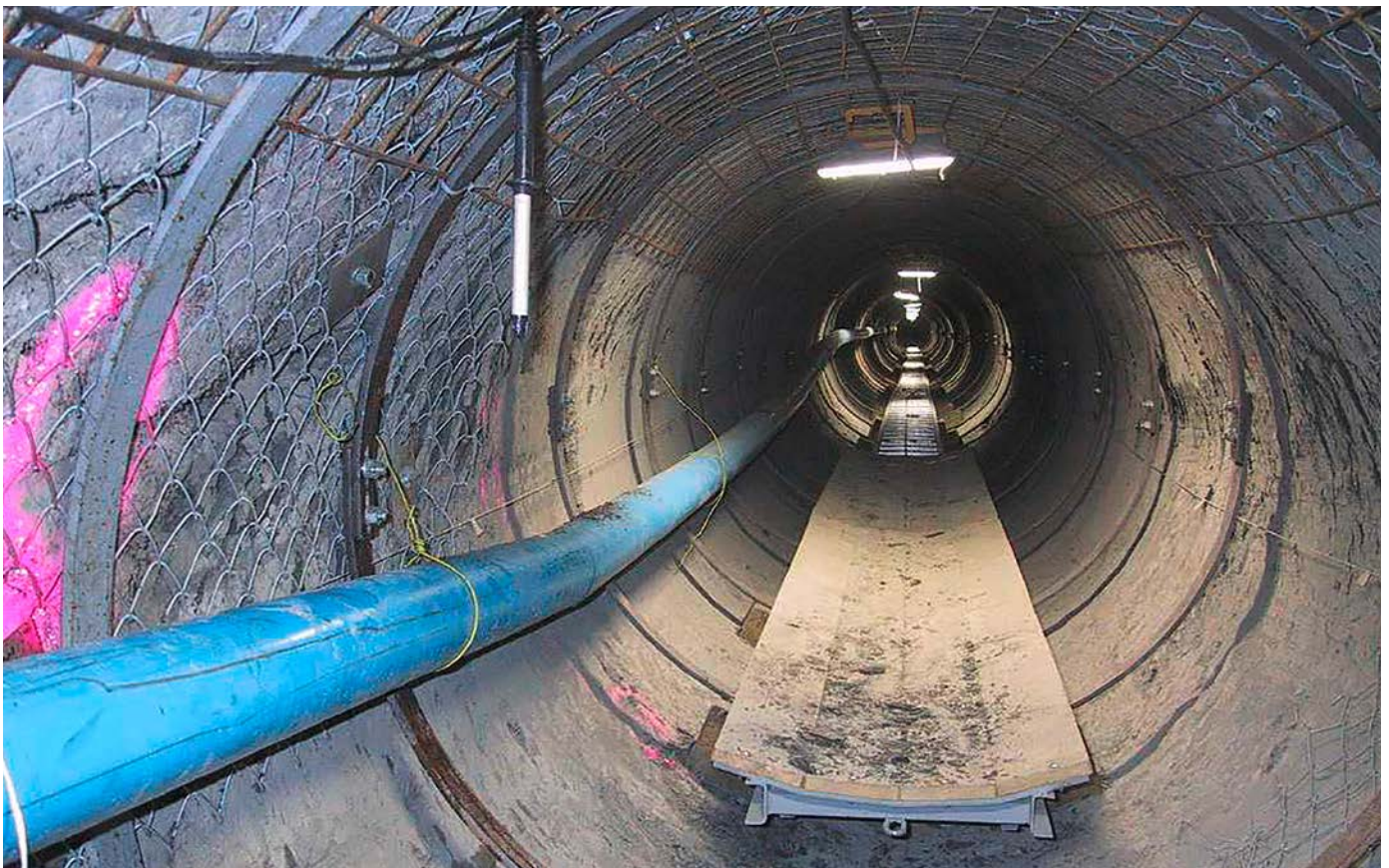
Blick in einen Experimentiertunnel im Felslabor Mt. Terri in der Schweiz
