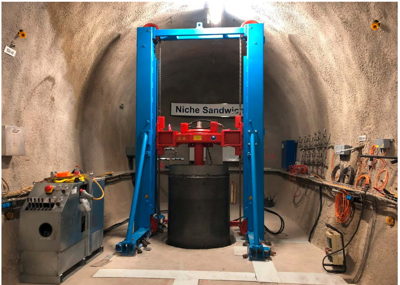
Bohranlage für Großbohrlöcher (120 cm Durchmesser) zur Erforschung von Verschlusselementen für Endlagerschächte nach dem Sandwich-Prinzip
