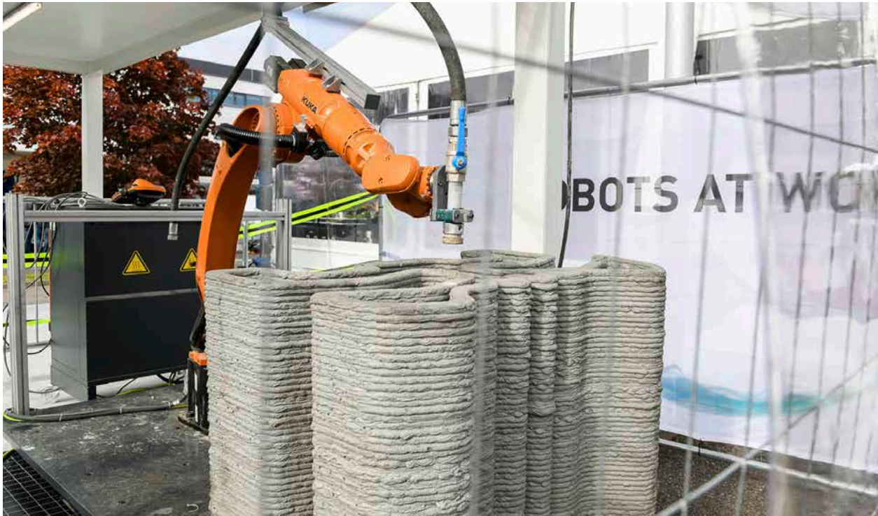
3D-Betondruck durch mobilen Druck-Roboter im vom BMWK geförderten Projekt 3DLight_OnSite
