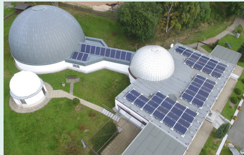
Auf der Volkssternwarte der Gemeinde Drebach hat die Bürgerenergiegenossenschaft ihr bislang größtes PV-Projekt (840 kWh) realisiert
