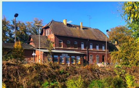
Bahnhofsgebäude Bad Dübén vom Gemeinschaftsgarten aus (Foto: T. Reinsch)
