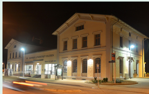
Die Bahnhof Lutherstadt Eisleben eG lässt das historische Gebäude in neuem Glanz erstrahlen (Foto: eD-regional)
